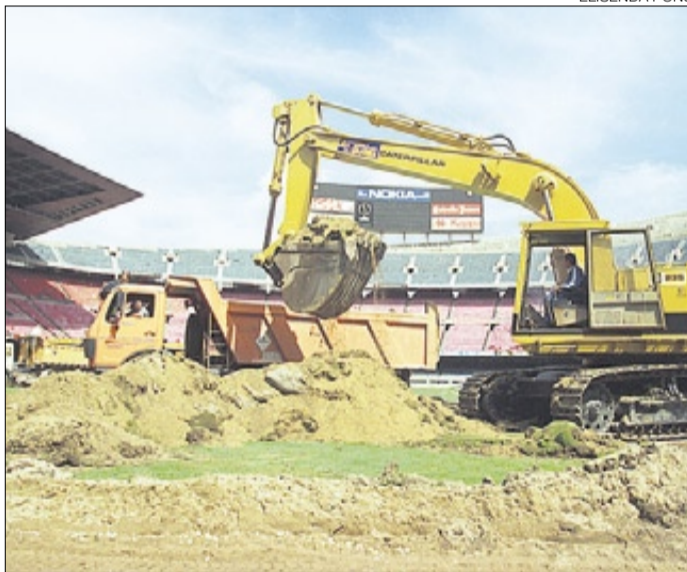
▶ Obres de remodelació de l'estadi el 1994.
