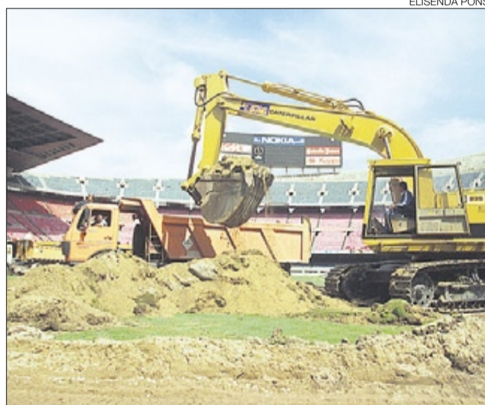
▶ Obres de remodelació de l'estadi el 1994.
